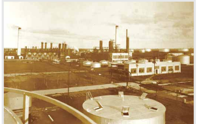
Chimeneas. Los frigoríficos fueron un símbolo de la localidad
