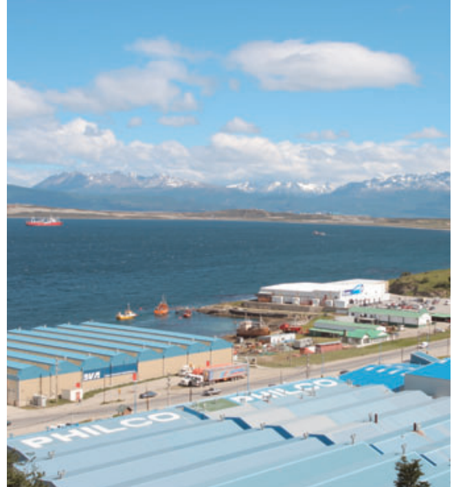
Vista panorámica de un parque industrial en la ciudad de Ushuaia, provincia de Tierra del Fuego.
